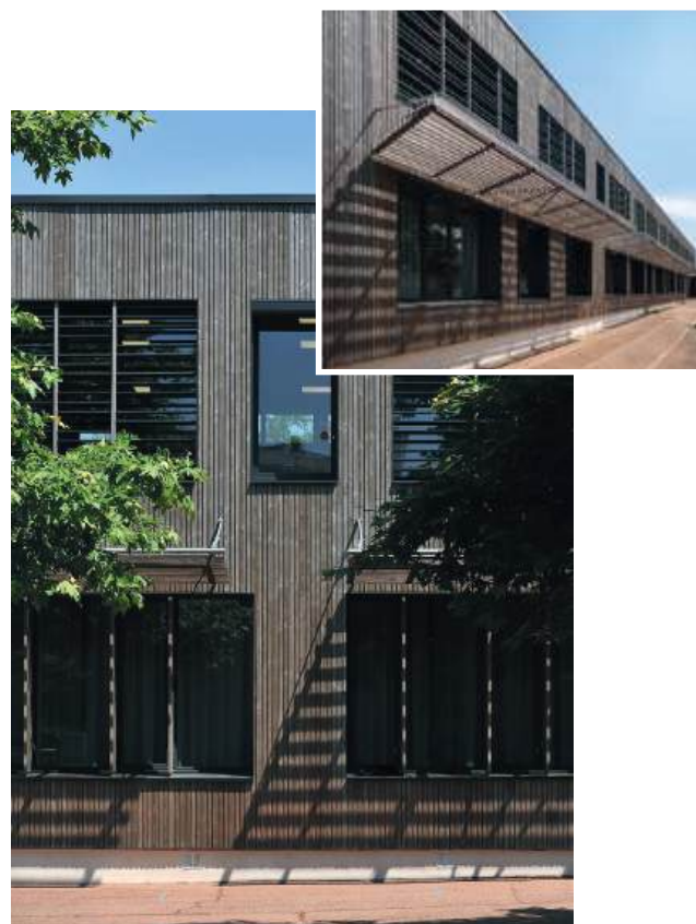
Rénovation thermique du groupe scolaire Les gémeaux - 69 - Crédit photo : ferrandsigal.fr/portfolio
